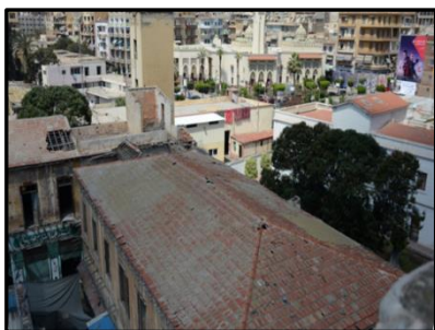
لوحة رقم (٣٢) الجناح الشمالي الشرقي ذات السقف الجمالوني المغطى بالقرميد - تصوير الباحث
