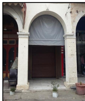
لوحة رقم (١١) العقود النصف دائرية بالقسم الأيمن من الواجهة الرئيسية الجنوبية الشرقية - تصوير الباحث
