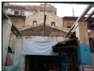
لوحة رقم (٢٩) الواجهة الخلفية للمدخل من داخل الرواق الذي يتوسط الفناء ويبدو فيها بقايا الرواق- تصوير الباحث
