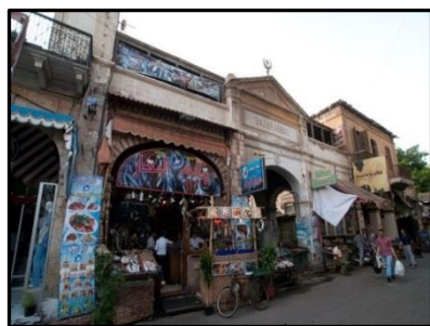
لوحة رقم (١) الواجهة الرئيسية الجنوبية الشرقية لبازار الخدوي عباس - تصوير الباحث
