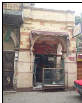
لوحة رقم (٩) واجهة الممر الشمالى الشرقى ويشغلها حاليا أحد المحلات الحديثة - تصوير الباحث
