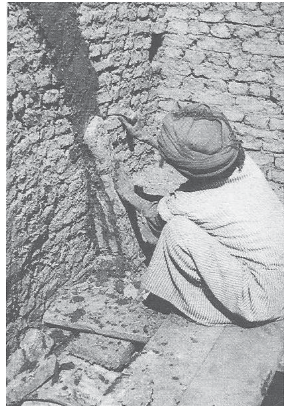
[F2] Construcción de una bóveda de adobe en Egipto.
