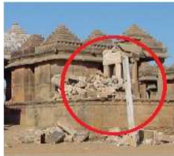
Fig. 3. Tensile Failure
