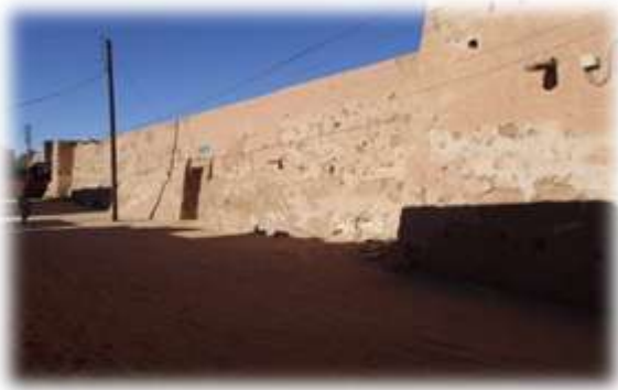
الصورة رقم 04 الجهة الشرقية للسور التي تحتوي المدخل
