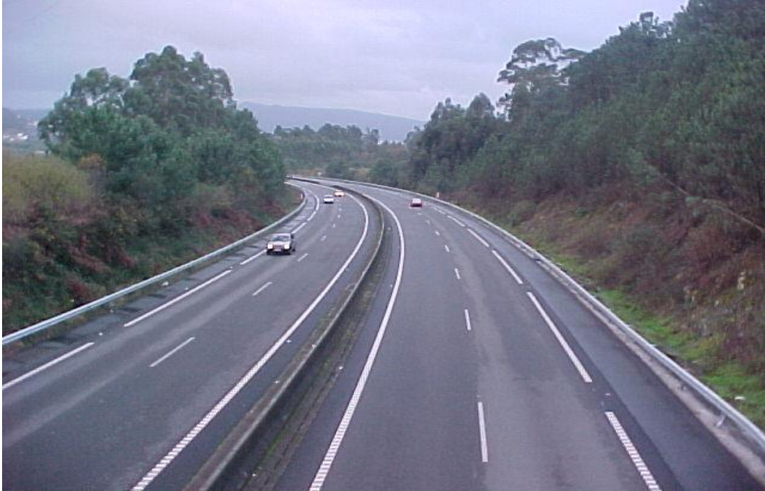
Fig.1. Desmontes en la A-9, con arbolado (A-9 Motorway)
