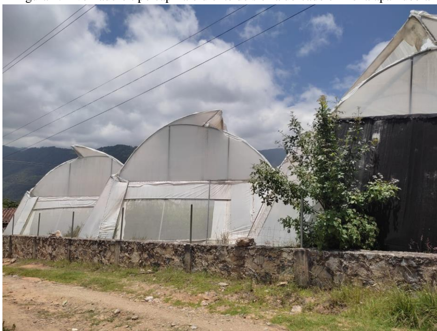
Figura 4. Invernadero tipo capilla o diente de sierra ubicado en Tonalapa Puebla
