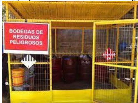
Fig. 2. Ejemplo de Almacén de Residuos Peligrosos
