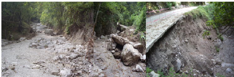
Fig. 5 - Gli effetti provocati dall'azione erosiva della colata del 30 luglio 2010, nel canale "Isca Longa". Isca Longa stream; erosional/depositional effects of the July 30, 2010 flood.
