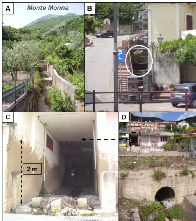
Fig. 9 - In sequenza, da A a D, sono rappresentati i vari tratti del canale che attraversa la frazione Vignale di San Cipriano Picentino. In A vi è la canalizzazione in calcestruzzo a monte dell'abitato. In B il tratto iniziale all'interno dell'abitato (cerchiato). In C il successivo tratto tombato. In D la tubatura di by-pass che raccorda il tratto precedente con quello esterno all'abitato.
