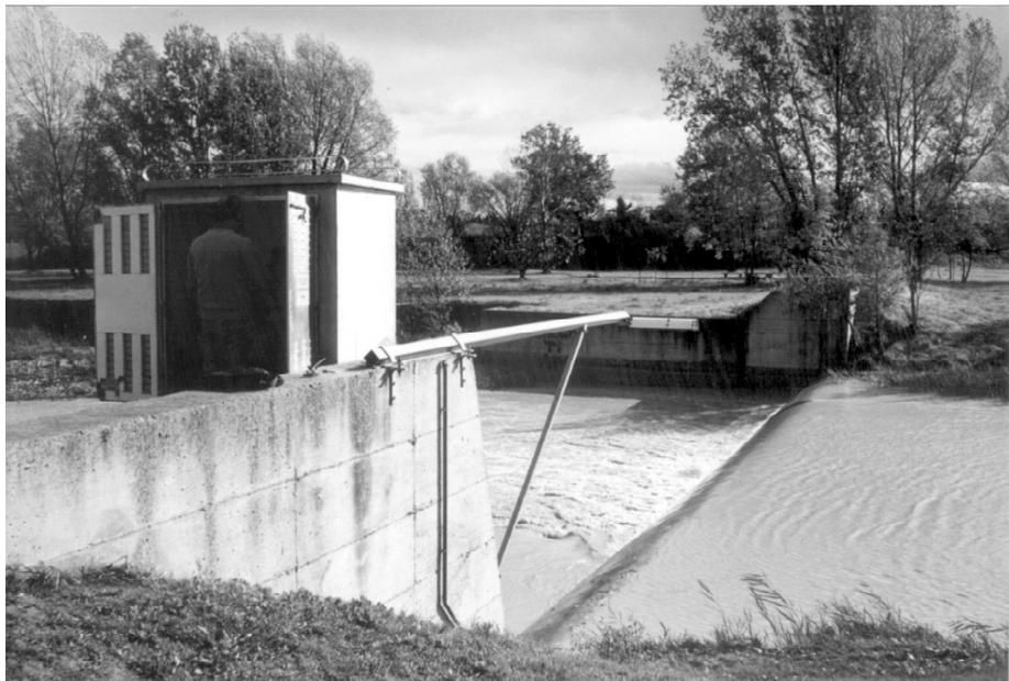
Fig. 2 - Stazione di monitoraggio idro-torbidimetrico sul Sillaro.
