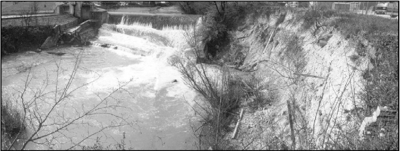
Fig. 2 - Fenomeni franosi connessi con l'approfondimento dell'incisione in alveo, in un tratto del fiume Chienti (a Tolentino) con evidente allargamento della sezione fluviale.
