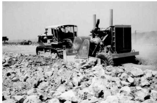
Fig. 3 - Operazioni di frangitura nelle Murge alte. Lo scheletro calcareo ed i frammenti di substrato presenti nel campo vengono triturati meccanicamente.
