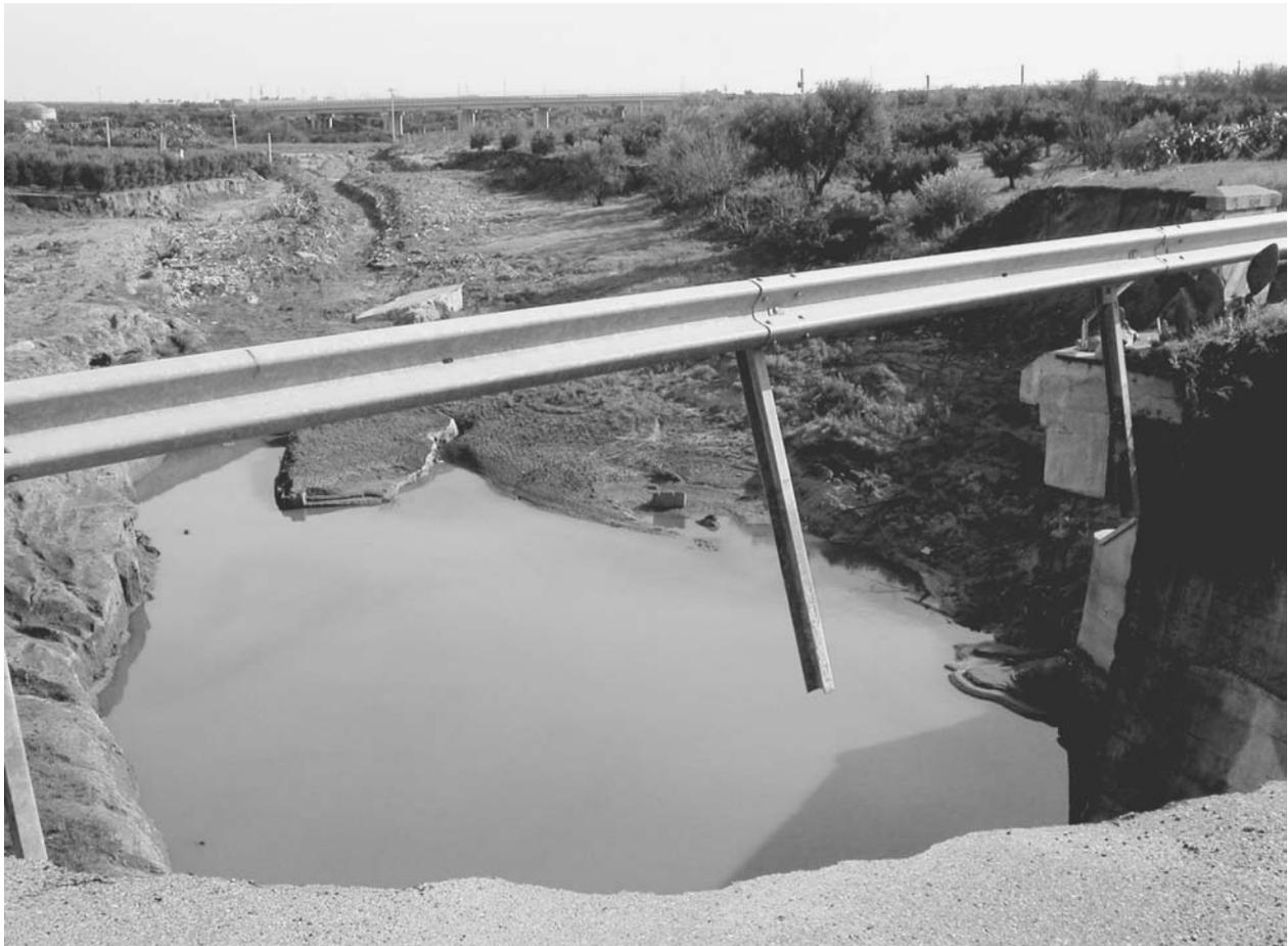
Fig. 11. Dettaglio dei danni prodotti nell'area di Palagiano durante lo stesso evento alluvionale di fig. 10.
