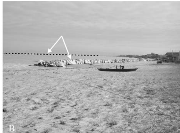
Fig. 2 – Esempi di difesa costiera lungo la spiaggia di Rio Vivo, rappresentati (A) da una barriera di massi a protezione delle abitazioni e (B) da una doppia scogliera indicata attraverso le due frecce.
