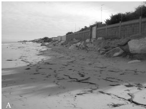
Fig. 2 – Esempi di difesa costiera lungo la spiaggia di Rio Vivo, rappresentati (A) da una barriera di massi a protezione delle abitazioni e (B) da una doppia scogliera indicata attraverso le due frecce.
