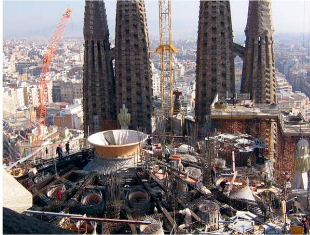
**Fig. 1.** Example of a complex formwork – La Sagrada Família, Antoni Gaudí, Barcelona.
