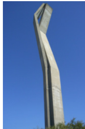
FIGURE 14 | F. Conduto, Troia , 1969.
