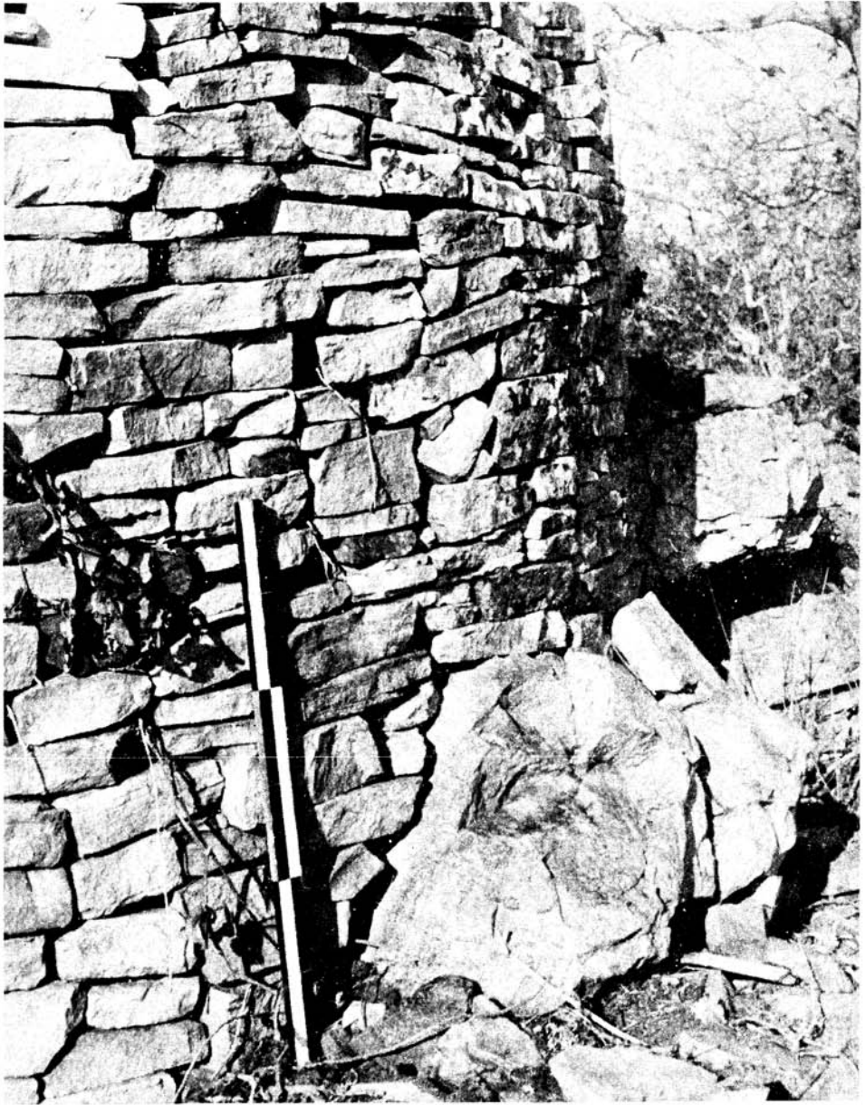
Fig. 4 Deel van 'n buitemuur.
