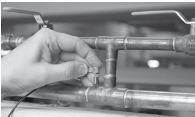
Rys. 4. Badania ultradźwiękowe połączeń mufowych instalacji rurowej [5]
