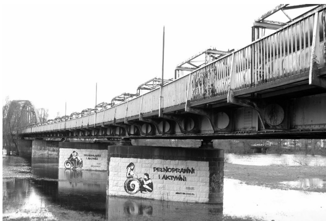
Rys. 2. Widok mostu na jednotorowej linii kolejowej nr 367 Zbąszynek-Gorzów
