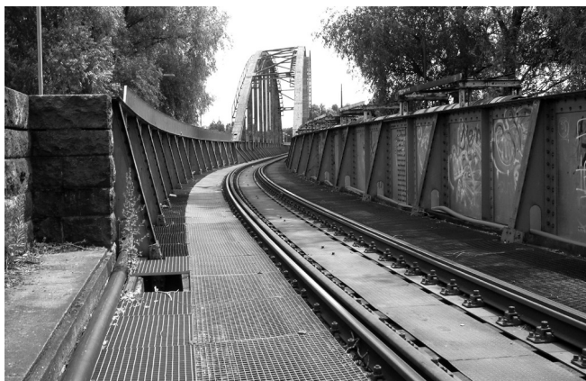
Rys. 3. Widok torowiska na moście przez Wartę na linii kolejowej Zbąszynek-Gorzów
