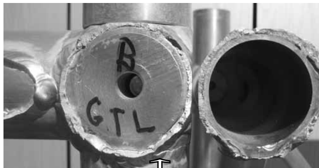
Rys. 7. Pęknięta spoina łącznika B (węzeł górny tylny, lewa strona). Dodatkowo widoczne pęknięcie spoiny prostopadłe do płaszczyzny rysunku – oznaczone strzałką
