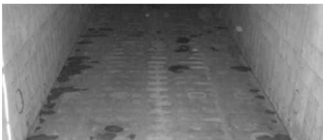
Rys. 7. Ładownia drobnicowca uniwersalnego przed czyszczeniem i konserwacją [9]
