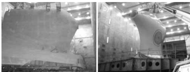
Rys. 3. Przygotowanie (a) i malowanie (b) tylnicy statku [9]
