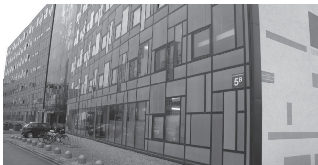
Rys. 1. Widok fragmentu budynku z elewacją wentylowaną Fig. 1. Partial view of the building with ventilated facade
