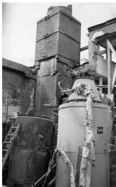
Rys. 3. Kocioł SR-25 po wybuchu. Widok zniszczonego kotła (z lewej) i budynku kotłowni Fig. 3. SR-25 boiler after the explosion. View of the damaged boiler (left) and the boiler house
