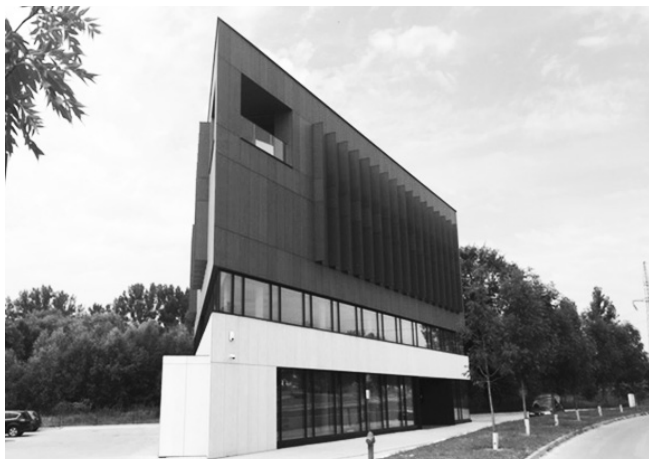
Rys. 1. Widok przykładowych elewacji budynków wykonanych z wykorzystaniem płyt włóknisto-cementowych Fig. 1. Examples of building facade with fiber-cement boards
