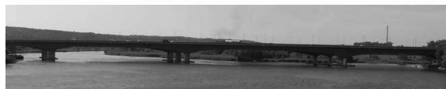
Rys. 2. Widok głównych mostów przeprawy przez Regalicę w Szczecinie
