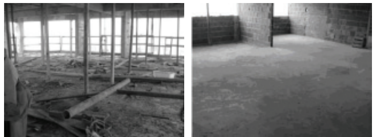
Figura 2 e 3 – Limpeza dos Pavimentos, antes e depois.
