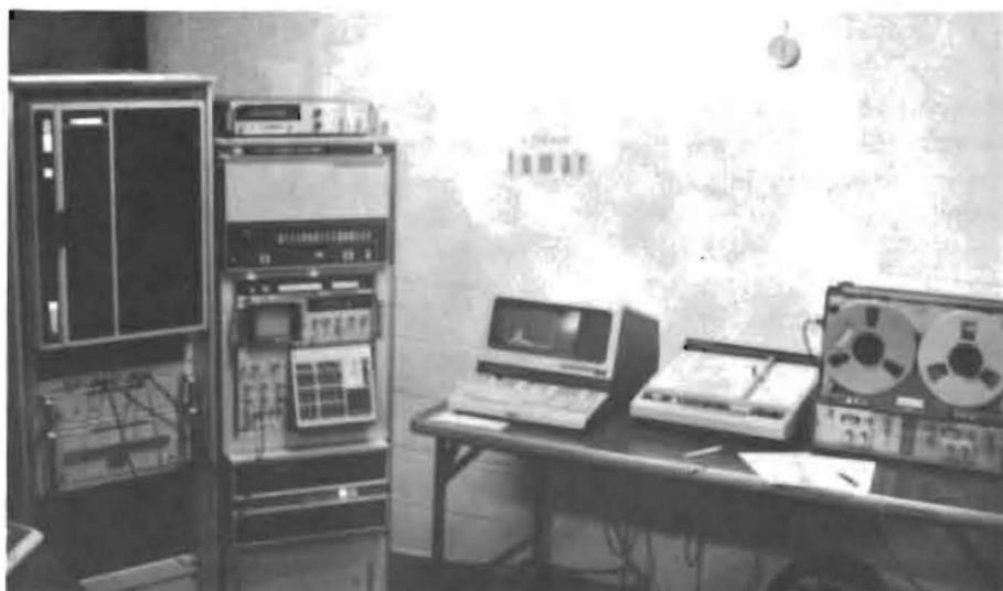
FIGURA 3. Analizador de Fourier. Sistema Hewlett - Packard 5451 C.
