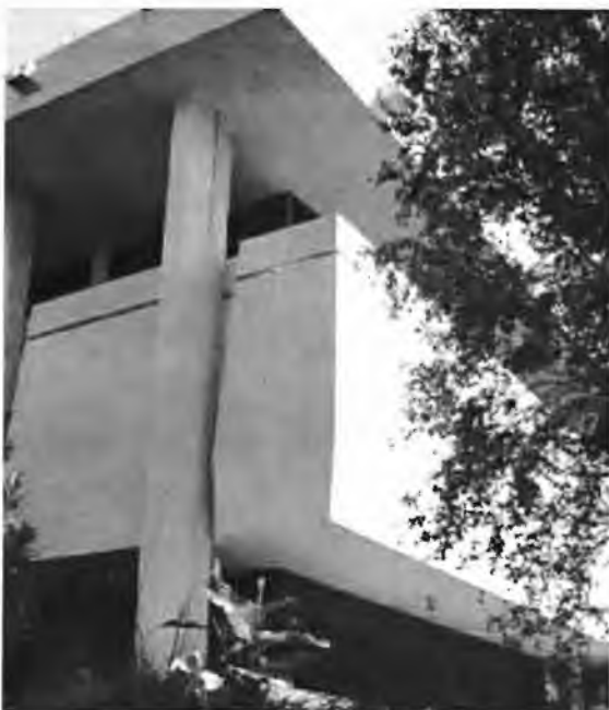
Fig 12: C.R. Swart-gebou – Ouditorium vault suidooste (Bron: Outeur)
