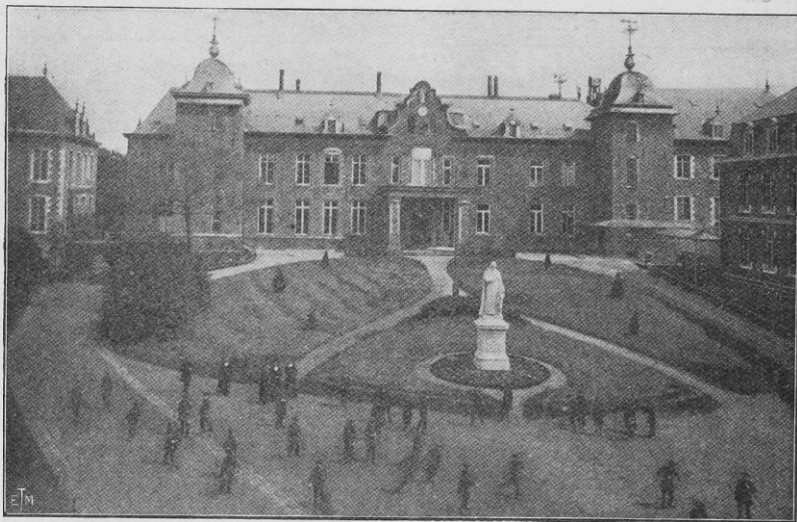
COUR D'ENTRÉE DE LA MAISON SAINT-JOSEPH, A LEMBECQ-LEZ-HAL
